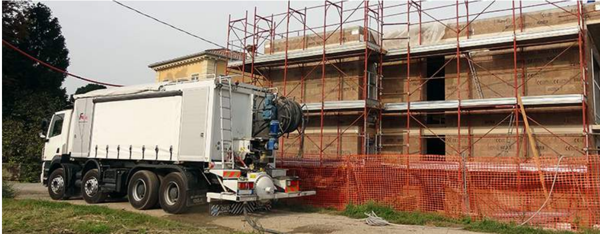
Abbildung 18: Mobile Mischstation im Baustelleneinsatz (Bildrechte liegen bei Bremat Holland BV)
