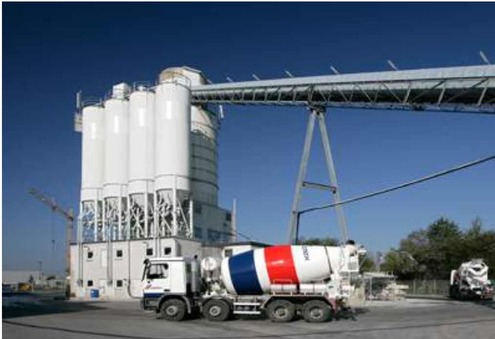
Abbildung 15: Abholung des Flüssigbaustoffes durch einen Mischer (Bildrechte liegen bei Cemex Deutschland AG)
