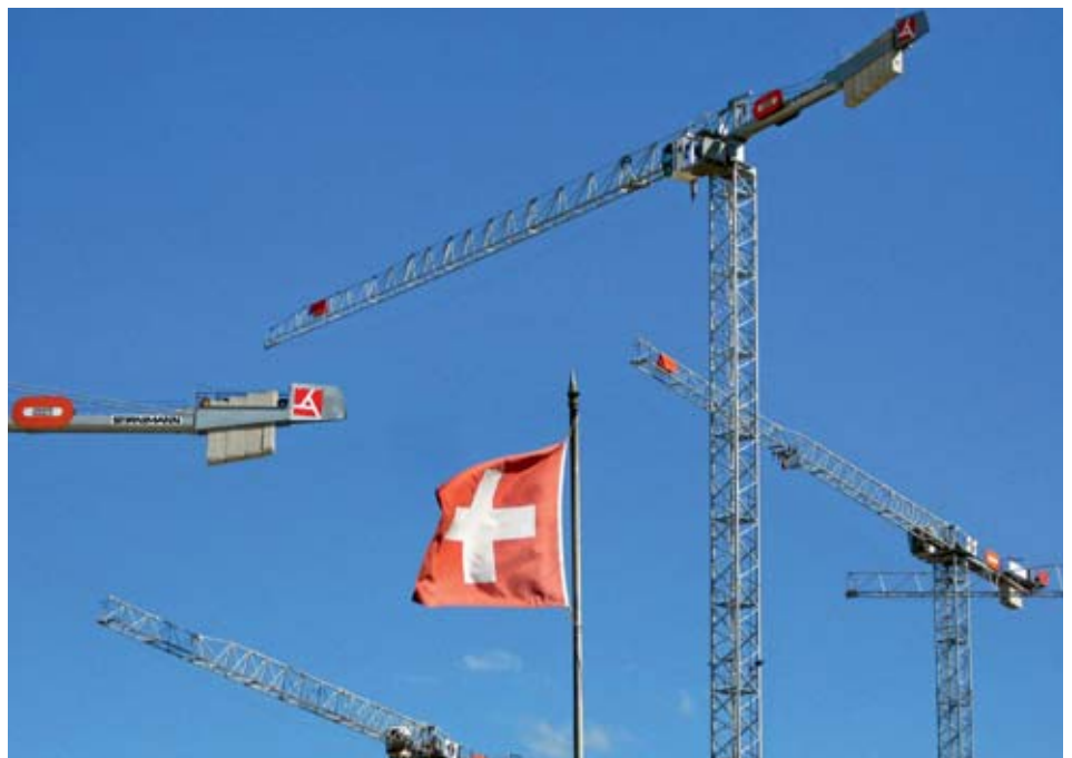
Die Schweiz verfügt über eine äußerst gesunde Wirtschaft, was sich auch in zahlreichen Bauaktivitäten – wie hier in Zürich-West – ausdrückt.
