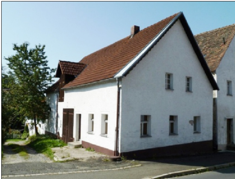
Abb. 2: Zu groß, zu klein? Dimensionen der Leerstandsgebäude
